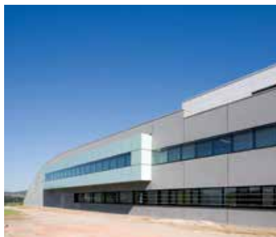
Beständigkeit mit Sichtbeton.
