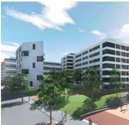
Bilfinger ist maßgeblich am Bau von Europas größter Passivhaussiedlung beteiligt.
