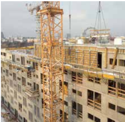
Im Wiener Prater errichtet Dywidag ein Studentenheim der neuen Generation.
