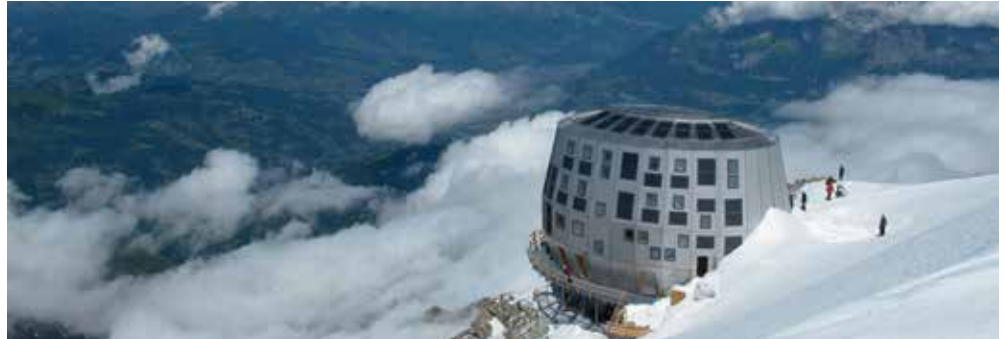
Das »Refuge du Goûter« ist das imposante Ergebnis herausfordernder Bauarbeiten.
