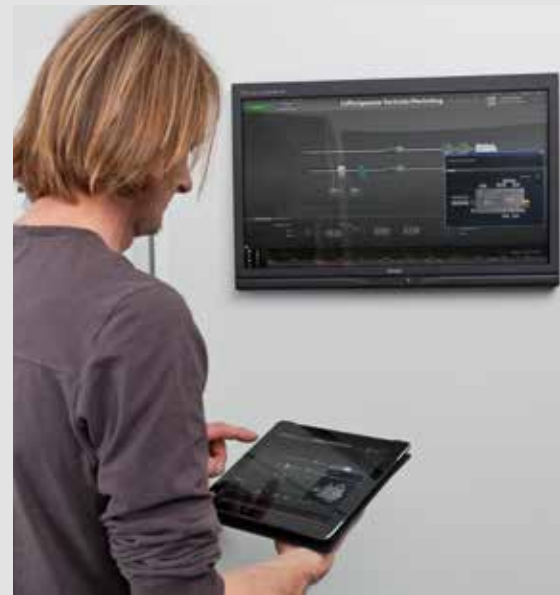
GEBÄUDEAUTOMATION schafft effiziente Bewirtschaftung von Heizung, Lüftung, Licht, Sicherheitsmechanismen und Kühlung. Die Steuerung läuft über zentrale Displays, aber auch über Stand-PCs.
